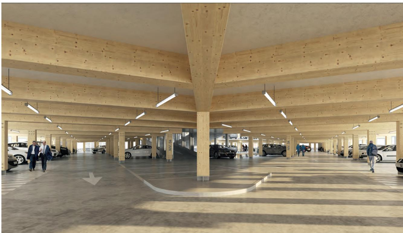
**Système constructif :** Structure poteau poutre bois
