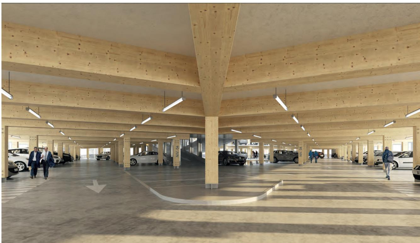
**Système constructif :** Structure poteau poutre bois
